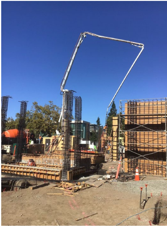
Figure 1 – Concrete Column Pour
